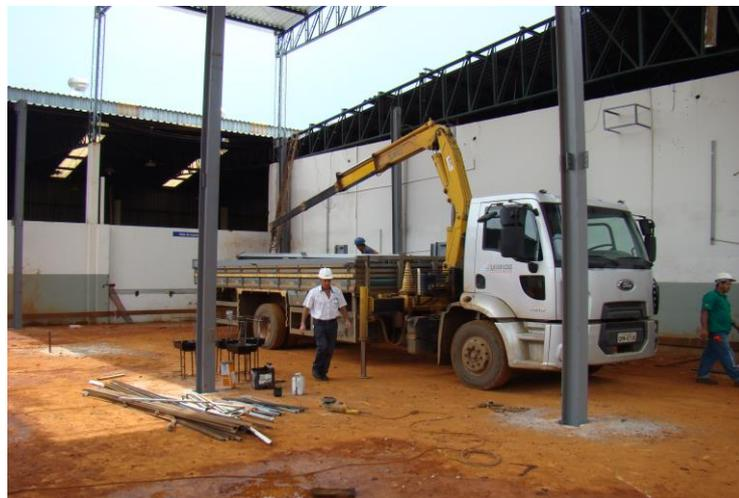
Com os pilares instalados e aprumados foi feita a instalação das vigas, essa montagem foi iniciada na altura do terceiro piso facilitando a entrada do caminhão munck no canteiro de obras. A figura 26 mostra parte das vigas já instaladas.
