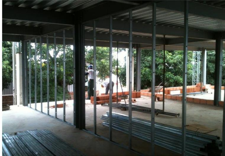
A figura 33 mostra a parede com Drywall quase concluída. Esse sistema possui o diferencial de ter facilidade na montagem, o que reduziu o prazo de entrega e diminuiu nos custos.
