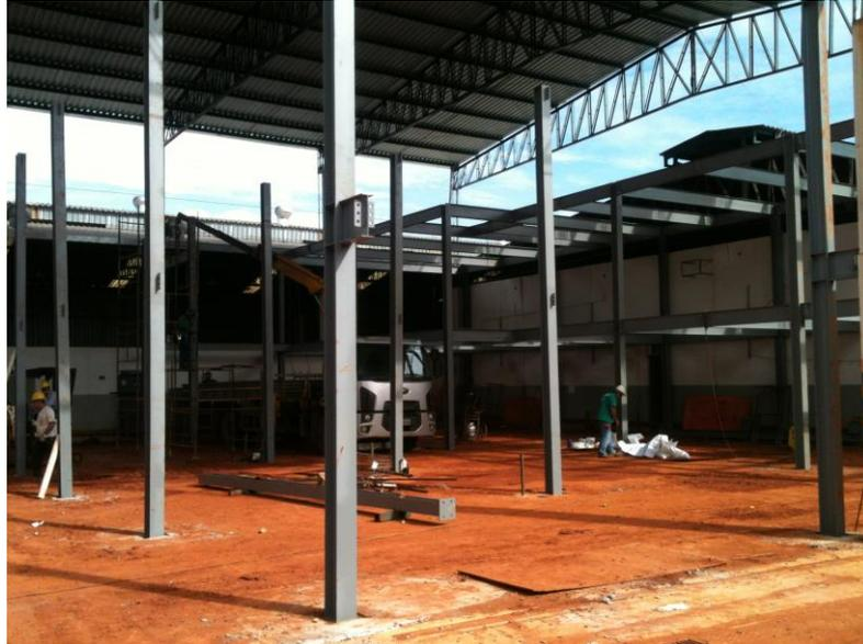
A figura 27 mostra que após a inserção de todas as vigas, foi realizada a montagem do steel deck, optou-se em iniciar pela primeira laje para facilitar a entrada e intervenções do caminhão munck nesta etapa da obra.
