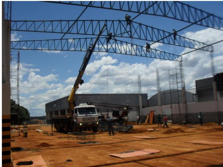
Com a primeira parte da cobertura já concluída houve a instalação dos pilares. A figura 25 mostra a cobertura já concluída com parte dos pilares já instalados no local.
