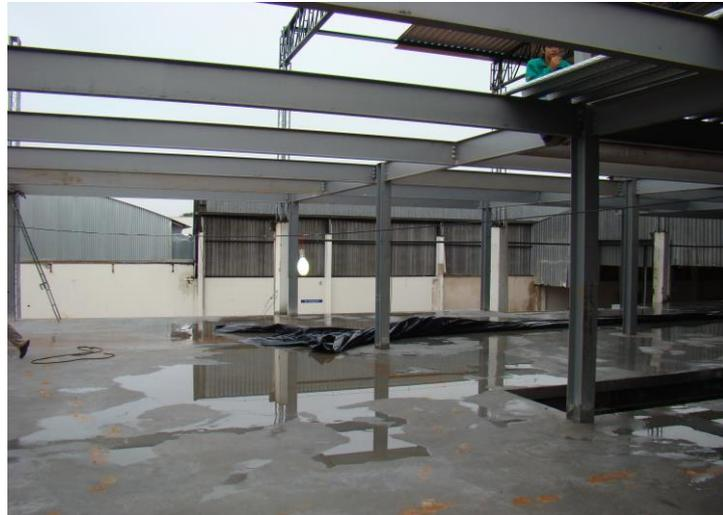
A figura 31 mostra o término da concretagem da segunda laje.
