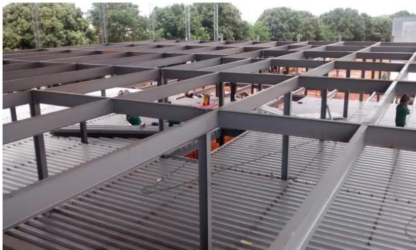
A figura 28 mostra a instalação dos conectores e tela. Os conectores de cisalhamento que assumem a função de estribo, permitem a ligação da viga metálica com o concreto armado e evita o deslocamento entre concreto e aço, dessa forma trabalha como viga T.
