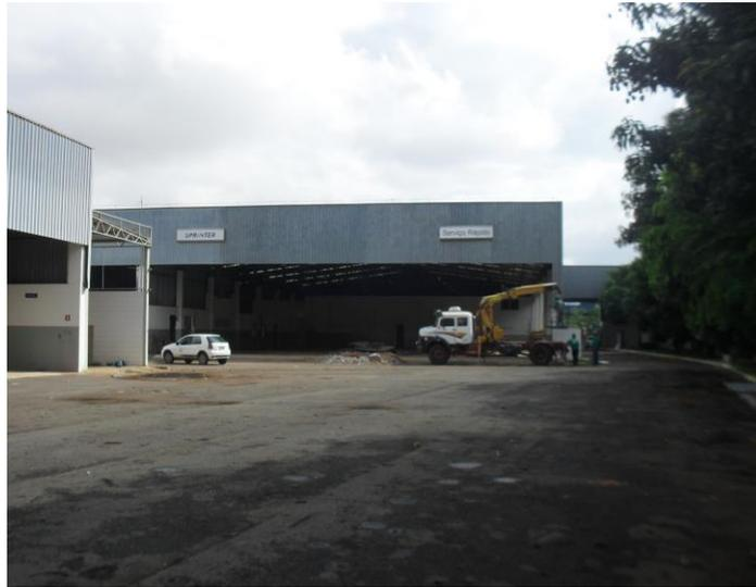
A figura 23 mostra o local sem o galpão em estrutura metálica, retirado para os ajustes necessários, liberando assim o espaço na obra para a marcação e gabarito para posteriormente dar início aos processos de fundações. A edificação que aparece ao fundo na foto é feita em estrutura de concreto armado e a edificação que aparece à esquerda é feita em estrutura metálica, ambas foram reaproveitadas e adaptadas ao projeto.
