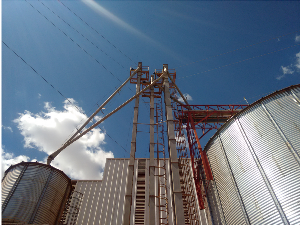
Figura 31 - Tubulação e Silos de expedição e estocagem
