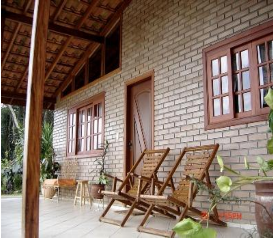
Figura 31: Varanda feita com a aplicação do tijolo solo-cimento
