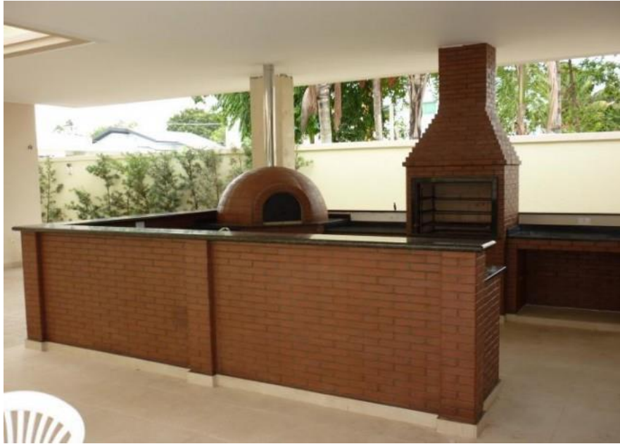
Figura 33: Área de lazer com acabamento feito em tijolo solo-cimento
