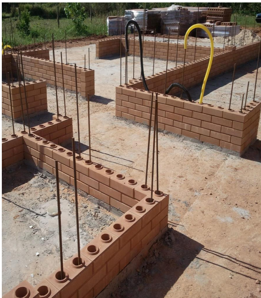
Figura 14: Exemplo da distribuição de colunas de sustentação
