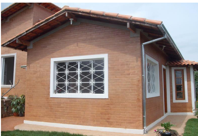
Figura 30: Vista lateral de uma construção feita com o tijolo solo-cimento
