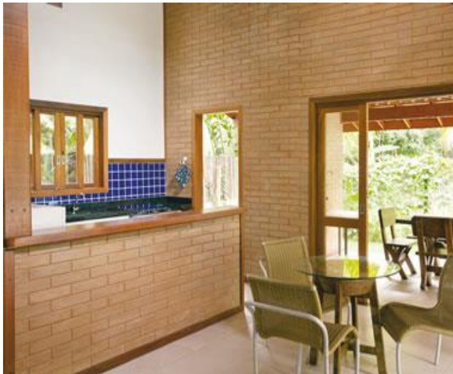
Figura 32: Cozinha com parte do tijolo solo-cimento com acabamento em reboco
