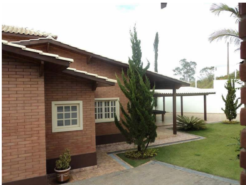
Figura 29: Construção com tijolo solo-cimento
