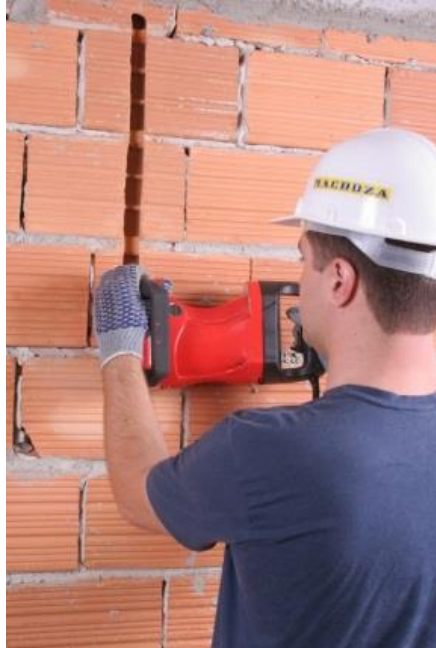
Figura 17: Tubulação e caixas nas paredes
