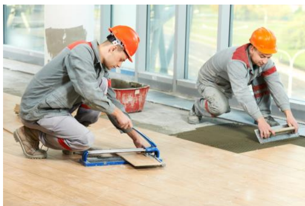
Figura 13: Assentamento de pisos
