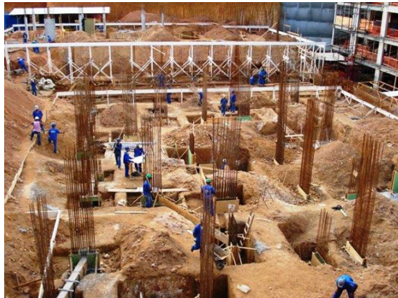
Figura 5: Montagem de armação de ferragem nas fundações profundas
