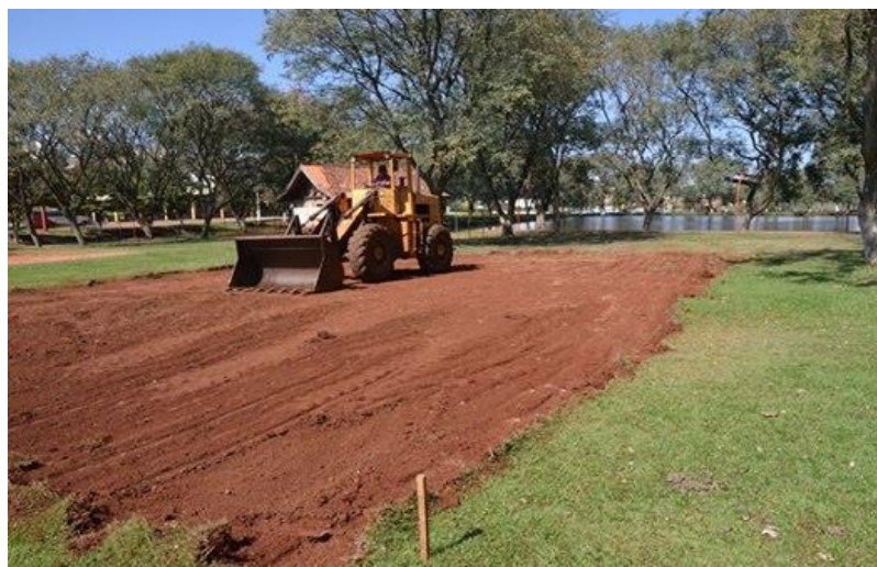
Figura 2: Limpeza do terreno
