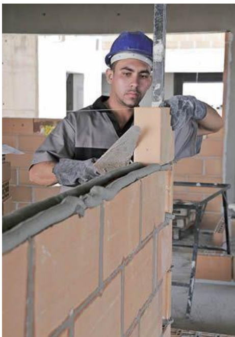
Figura 7: Construção de paredes
