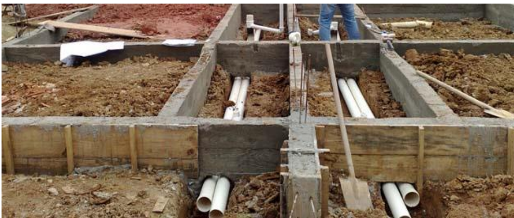
Figura 18: Tubulação de água pluvial
