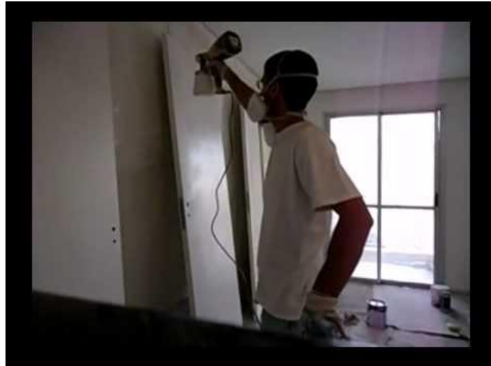
Figura 15: Pintura de portas e janelas
