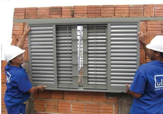
Figura 9: Instalação de Janelas
