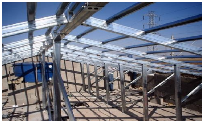
Figura 8: Estrutura do Telhado
