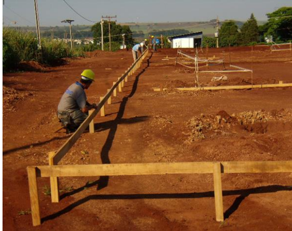
Figura 3: Marcação da obra
