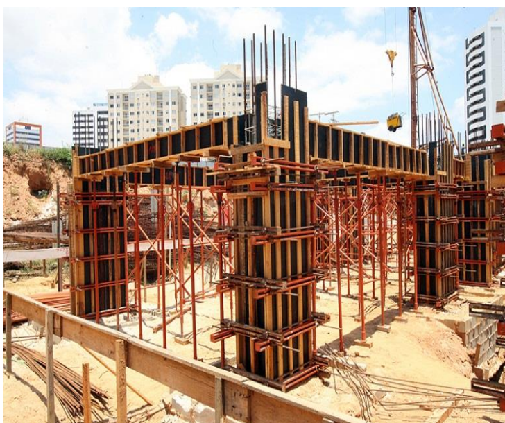
Figura 6: Montagem de formas
