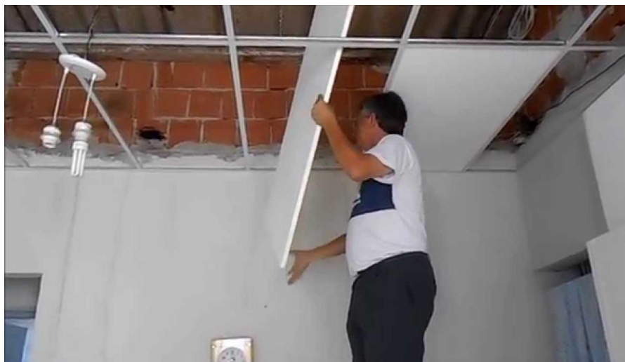
Figura 12: Instalação de forro
