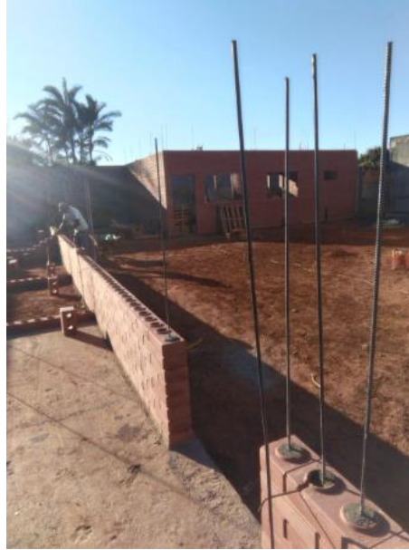
Figura 04 – Passagem das ferragens.
