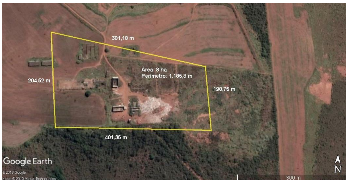
Figura 10 – Área de implantação do aterro sanitário da cidade de Tiros-MG
