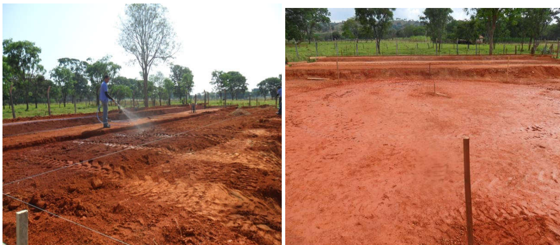
Fig. 10 e 11: compactação e taludes
