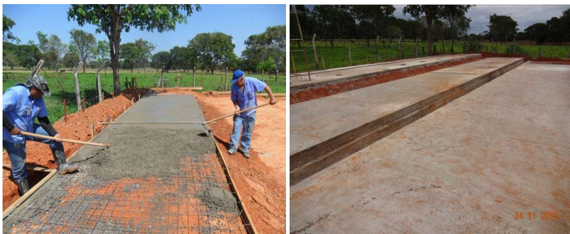
Fig. 16 e 17: concretagem
