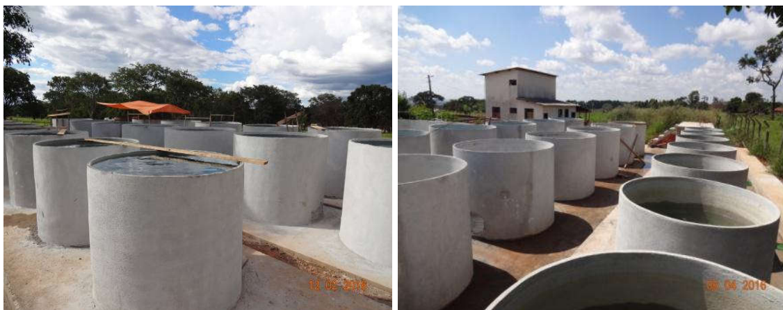
Fig. 25 e 26: cura do ferrocimento
