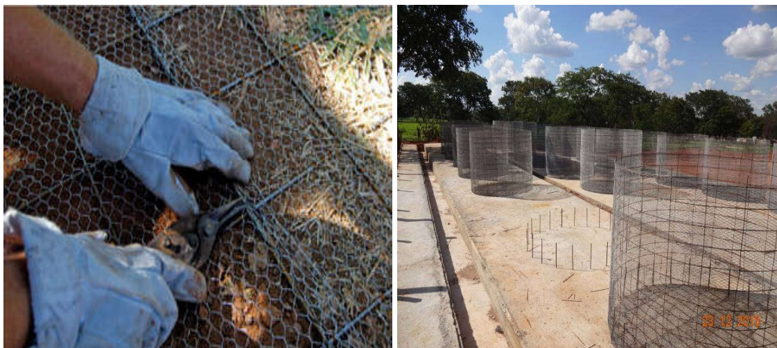
Fig. 18 e 19: Armação da estrutura ferrocimento
