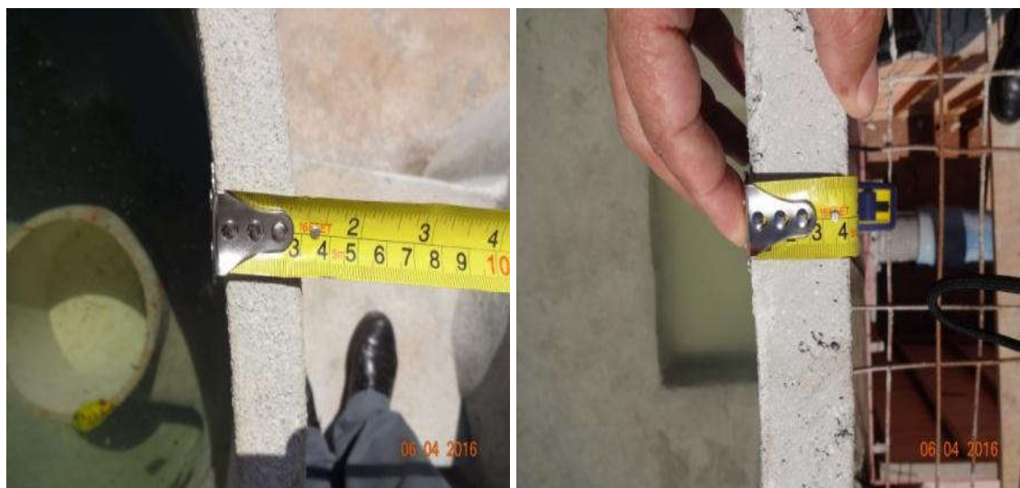
Fig. 29 e 30: Espessura das paredes dos reservatórios
