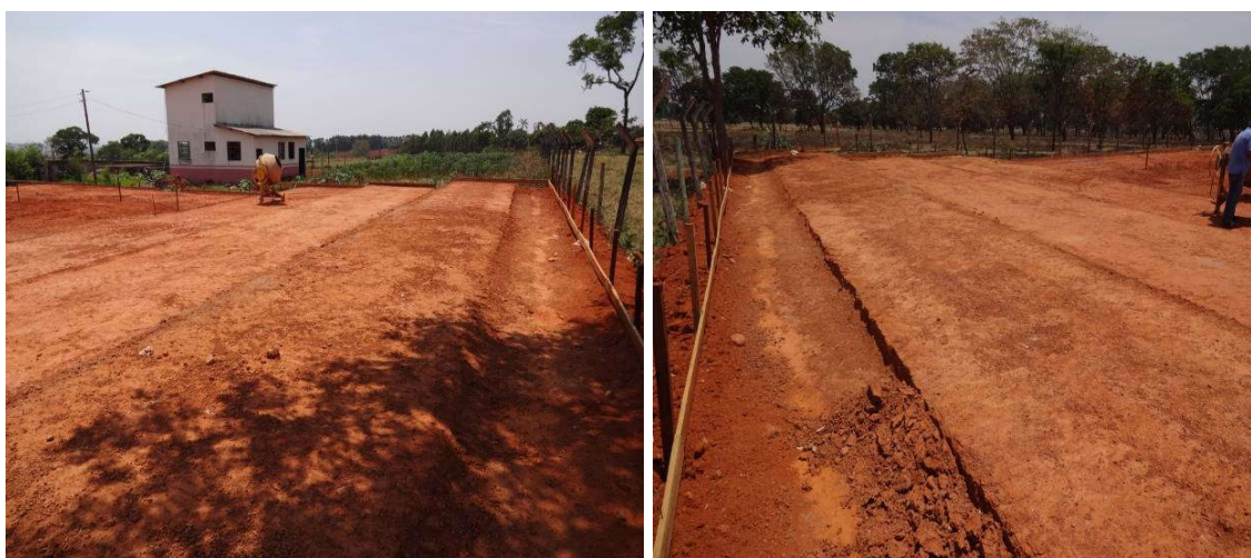
Fig. 12 e 13: base solo cimento
