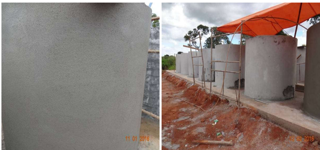
Fig. 23 e 24: Acabamento do ferrocimento
