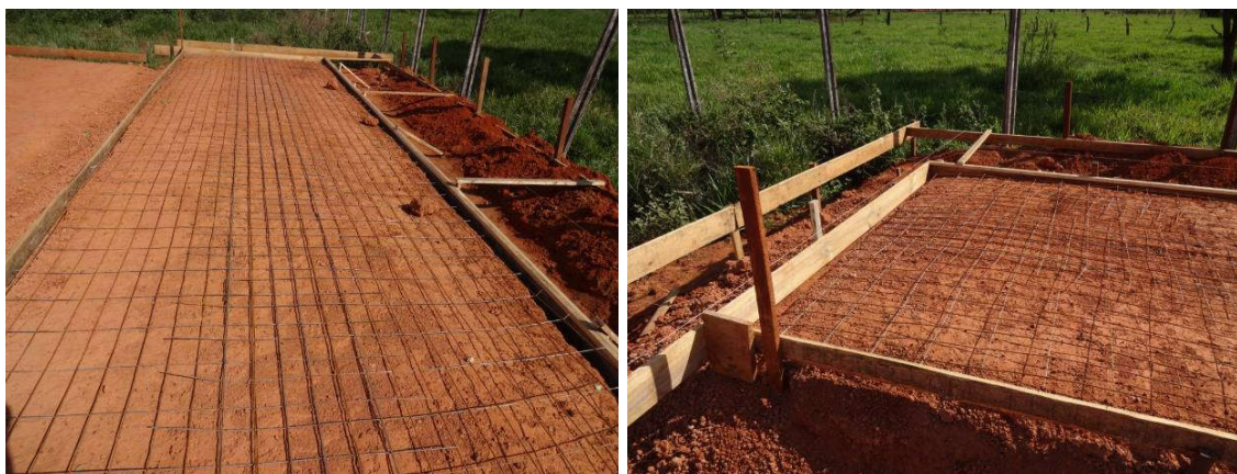
Fig. 14 e 15: Fôrma e armação para concreto convencional
