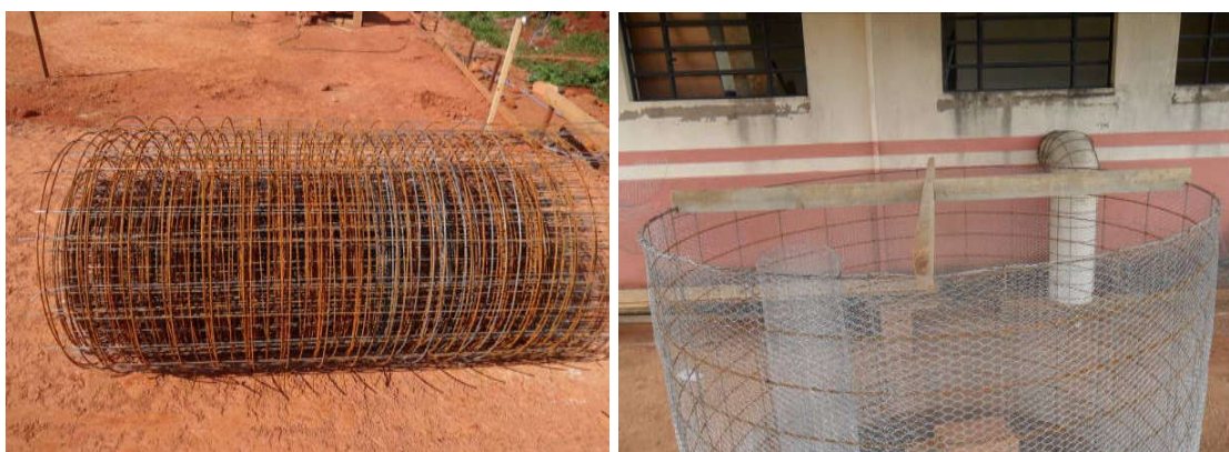
Fig. 06 e 07: malha de aço e tela
