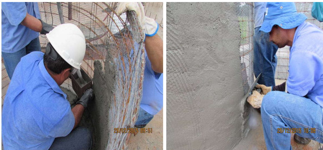
Fig. 21 e 22: Argamassagem do ferrocimento
