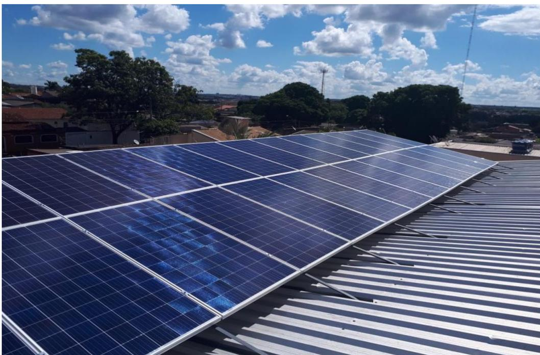
Figura 10 - módulos fotovoltaicos instalado sistema on grid
