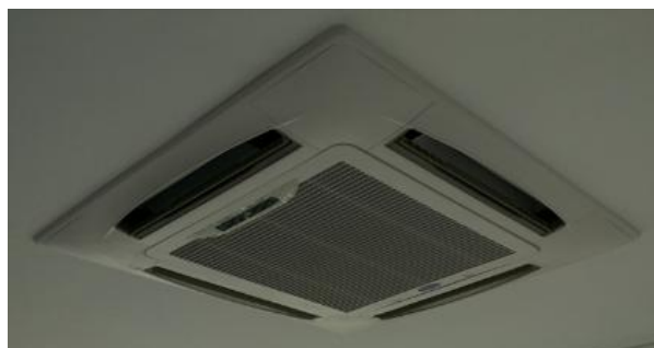
Figura 43 – Evaporadora tipo Cassete
