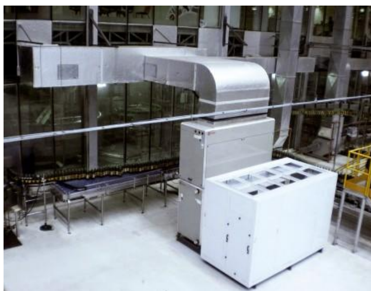
Figura 5 – Sistema VAV com dutos
