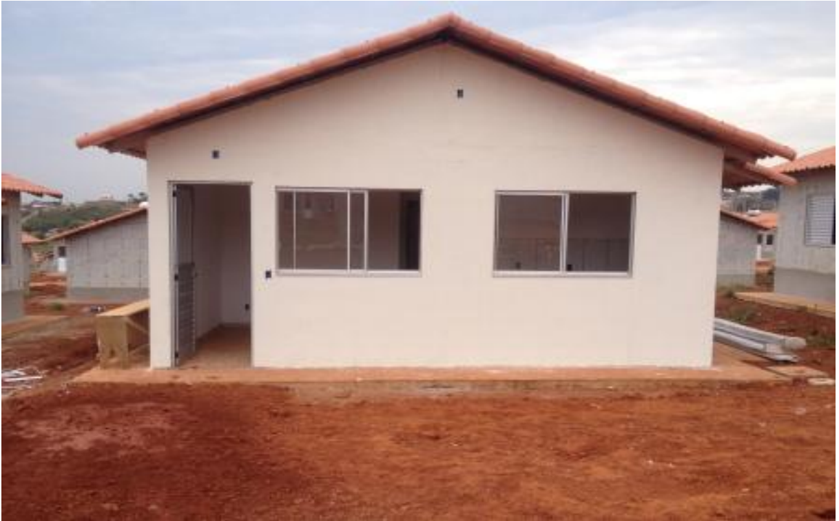
Fig. 31 e 32 - Casa finalizada e imagem panorâmica da obra.
