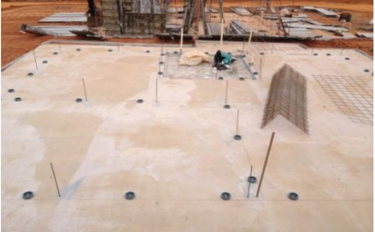
Fig. 12 e 13 - Próxima etapa após o radier concluído é a marcação, usando as bolachas, para a colocação das armaduras.
