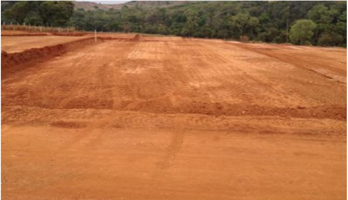
Fig. 5 - Marcação do radier com a rede de esgoto pronta.
