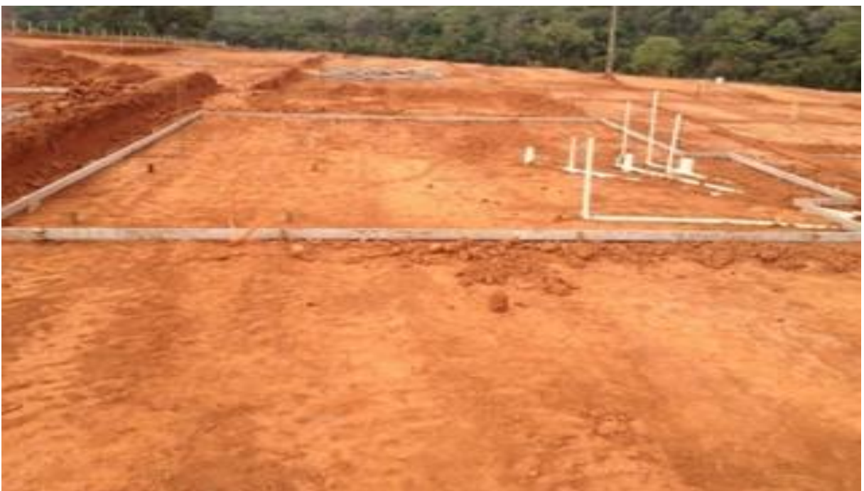
Fig. 5 - Marcação do radier com a rede de esgoto pronta.
