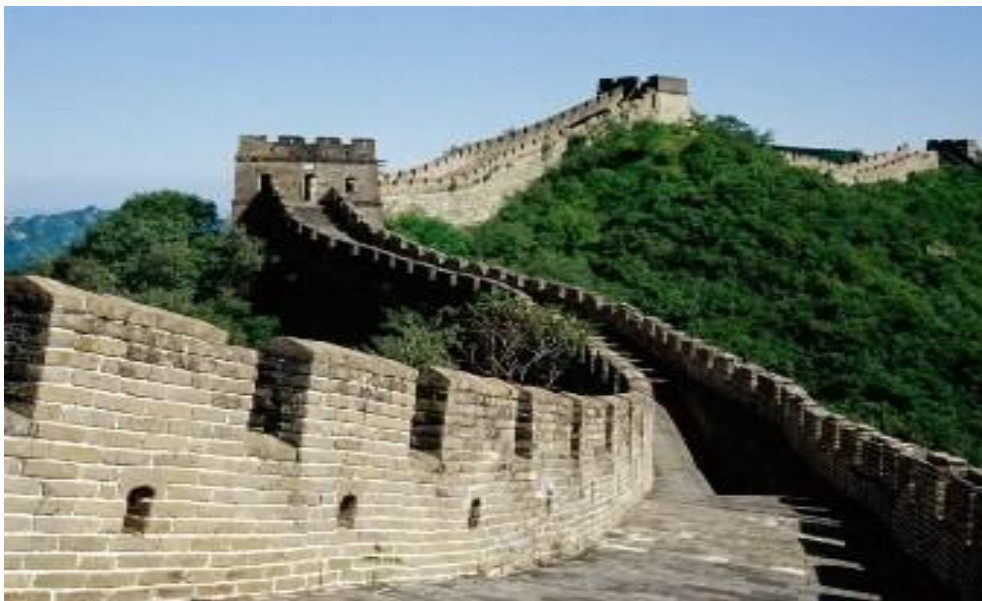
Figura 1: Muralha da China
