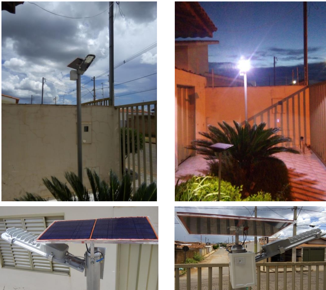
Figura 25: Imagens in loco do poste de iluminação
