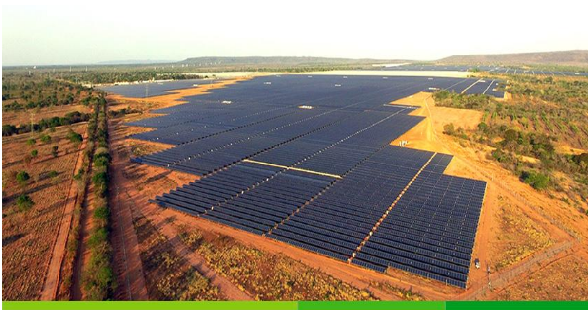
Figura 07: Complexo fotovoltaico instalado no município de Pirapora, Minas Gerais
