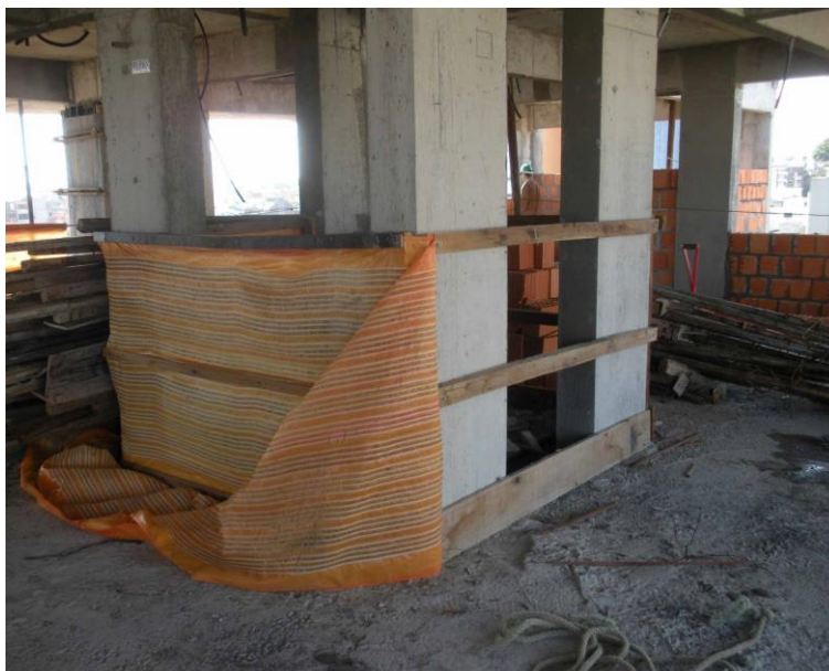
Figura 7 - Escoras e proteção para poço de elevador
