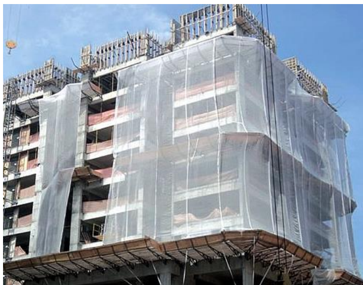
Figura 3 – Rede de proteção
