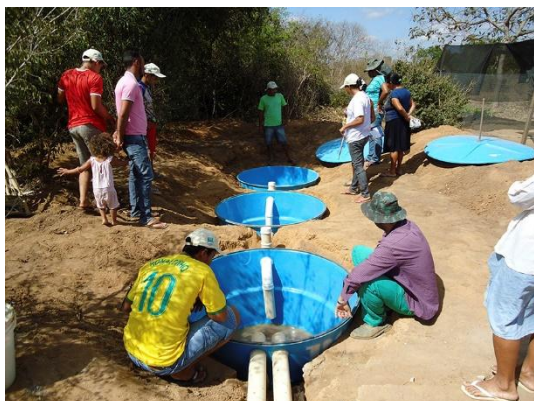
Figura 11 – Caixa d'água sendo aplicada na construção da fossa séptica
