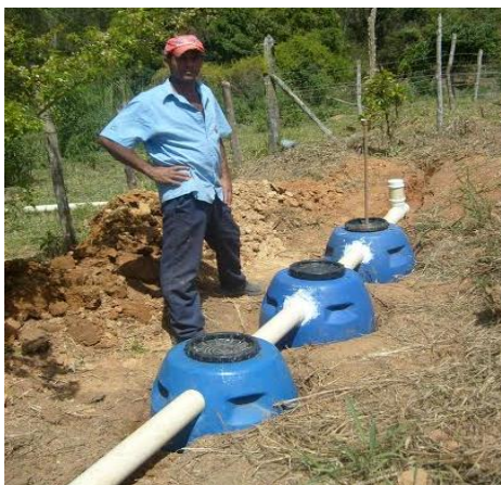
Figura 16- Fossa séptica construída com tambores de plástico
