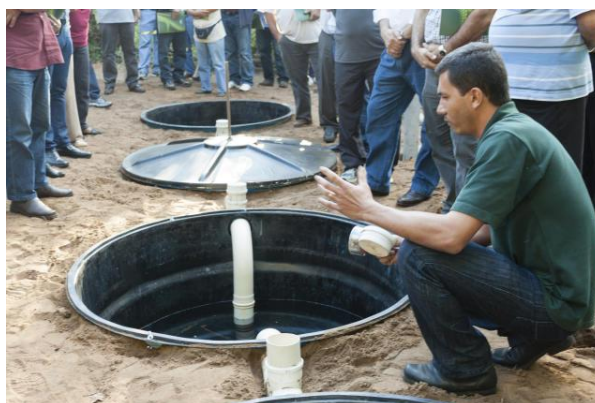
Figura 15 - Fossa séptica de caixa d'água de polietileno em construção
