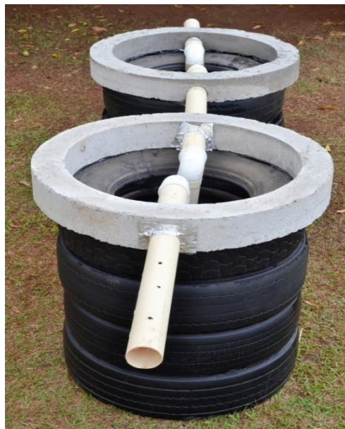
Figura 18 – Encaixe dos anéis nos módulos com a canalização fixada
