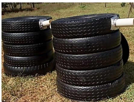
Figura 17 - Montagem dos módulos de pneus com espera das canalizações
