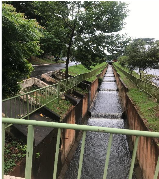
Figura 27 – Canalização na avenida Ivan Borges Porto
