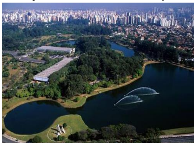
Figura 12 – Reservatório de retenção
