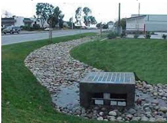
Figura 14 – Trincheira de infiltração
