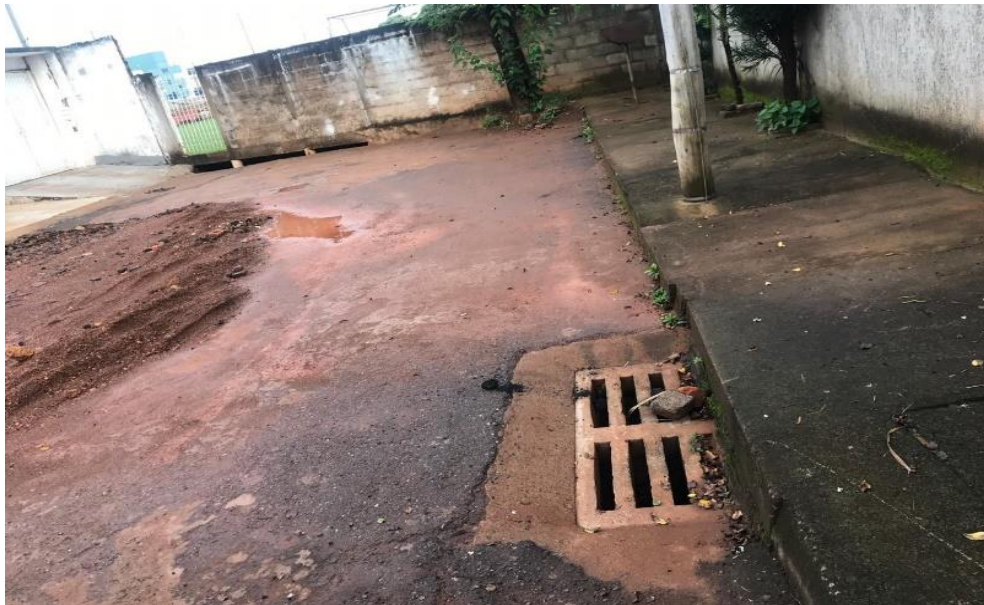
Figura 26 – Elementos de microdrenagem
