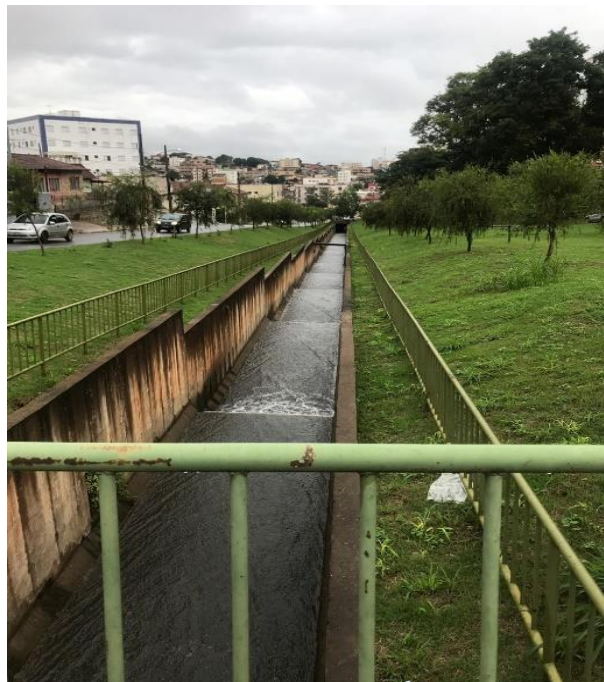
Figura 42 – Trecho em canalização aberta na avenida Ivan Borges Porto
