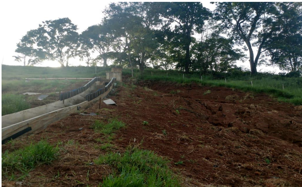
Figura 44 – Processo erosivo na cabeceira do Córrego do Monjolo
