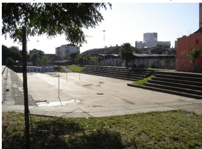
Figura 11 – Reservatório de detenção
