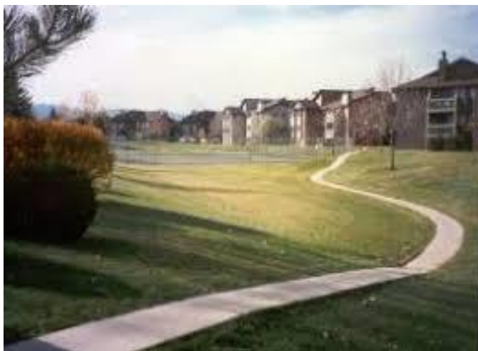
Figura 13 – Vala de infiltração
