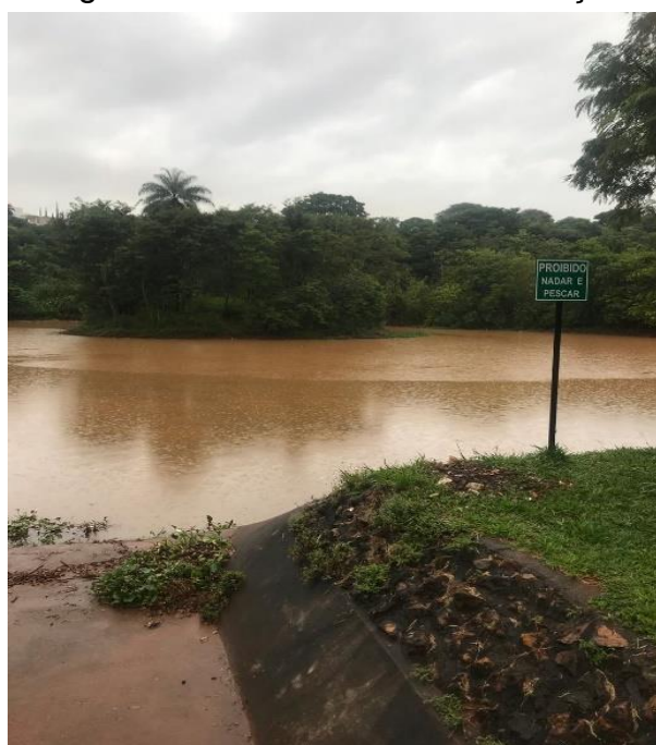
Figura 24 – Reservatório de retenção
