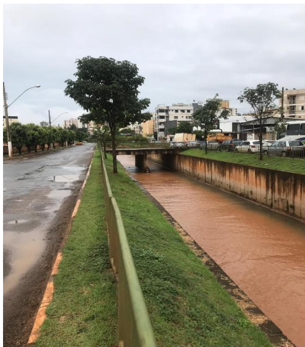
Figura 18 – Canalização e retificação de cursos d'água
