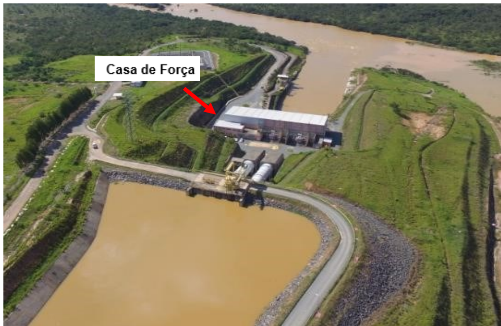
Figura 9. Casa de Força Retiro Baixo (Fonte: Documentos Operacionais da UHE Retiro Baixo, 2018).
