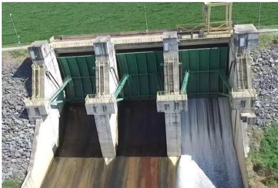
Figura 13. Vertedouro Retiro Baixo (Fonte: Documentos Operacionais da UHE Retiro Baixo, 2018).
