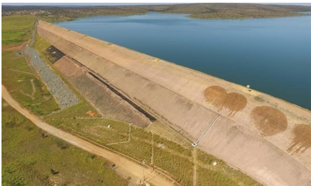
Figura 15. Barragem de Terra Retiro Baixo (Fonte: Documentos Operacionais da UHE Retiro Baixo, 2018).
