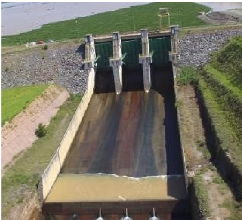
Figura 12. Vertedouro Retiro Baixo (Fonte: Documentos Operacionais da UHE Retiro Baixo, 2018).
