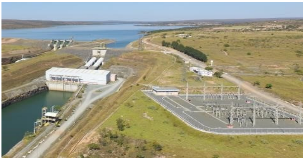
Figura 17. Subestação UHE Retiro Baixo(Fonte: Documentos Operacionais da UHE Retiro Baixo, 2018).
