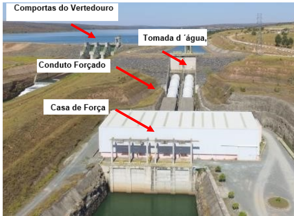
Figura 8. Conduto Forçado Retiro Baixo (Fonte: Documentos Operacionais da UHE Retiro Baixo, 2018).
