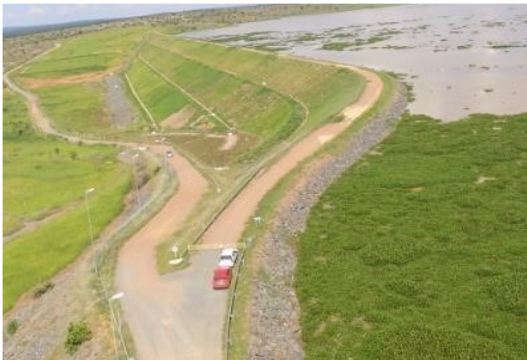
Figura 14. Barragem de Terra Retiro Baixo (Fonte: Documentos Operacionais da UHE Retiro Baixo, 2018).
